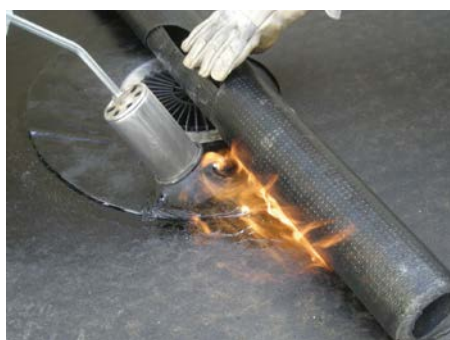
4. Наклеить 2-й слой гидроизоляции (до обжимного фланца)
