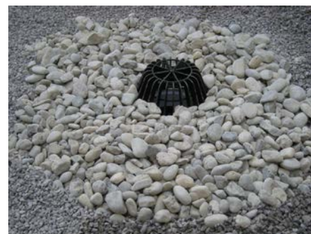
12. Засыпать гравием остальную поверхность кровли
