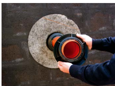
4. Установить фиксирующую гайку
