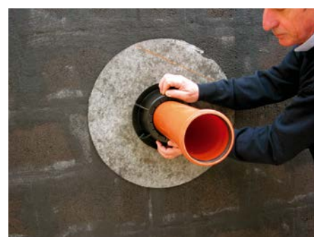
6. Затянуть фиксирующую гайку
