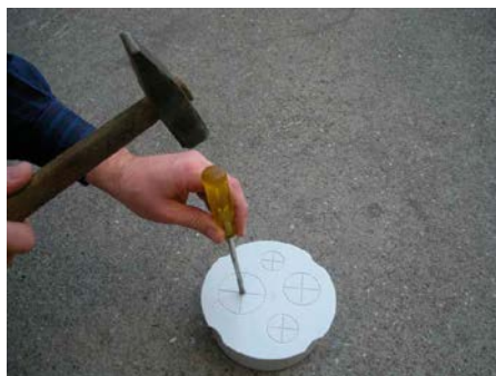
2. В монтажном элементе подготовить отверстия нужного диаметра
