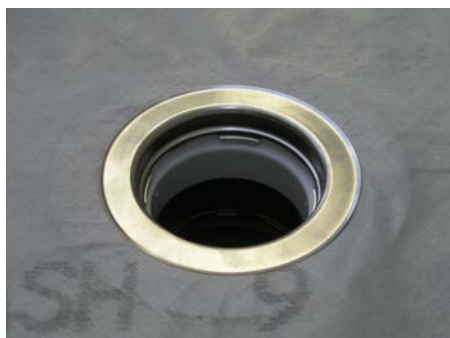
10. Зажать фильтрующий слой фиксирующим фланцем элемента HL350.0
