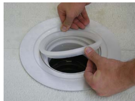
9. Убедиться в правильности установки прозрачного пластикового кольца
