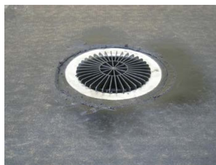
5. Так должна выглядеть воронка после укладки гидроизоляции
