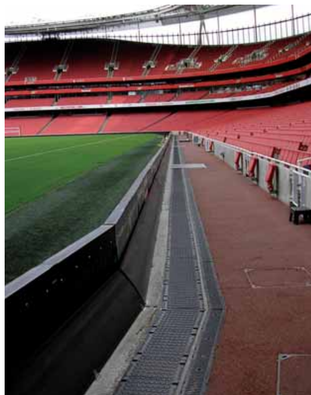
Сервисные каналы на стадионе Arsenal
