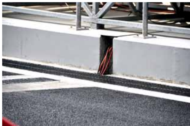
На гоночной трассе «Moscow Raceway», Московская область, Волоколамский район. Сервисные каналы ХАУРАТОН установлены на пит-лейне и вдоль пит-улла
