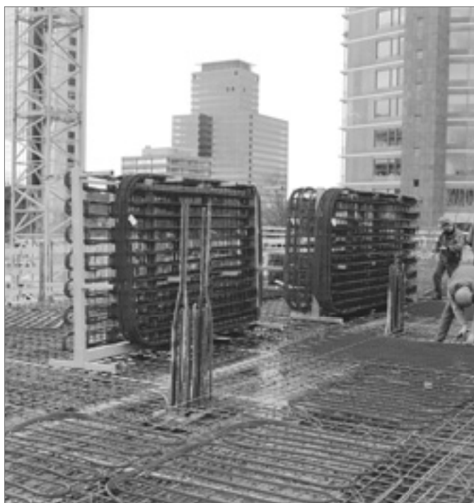
Подогрев и охлаждение ядра бетонных перекрытий
