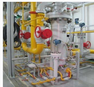
Оборудование подготовки газа (ОПГ) моноблочного исполнения
