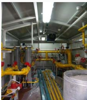
Блочные установки подготовки топливного газа моноблочного исполнения
