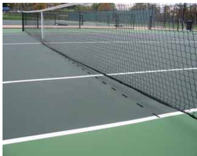
Щелевые каналы в середине поля
