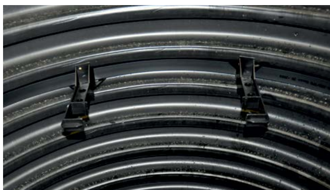
Рис. 6. Предварительный монтаж держателя лестницы в шахтной трубе.
