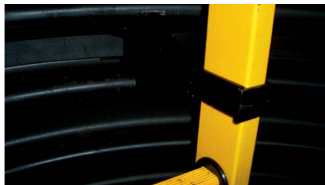
Рис. 7. Установка заглушек в кронштейны.
