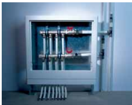
Подводка трубы к коллекторам
