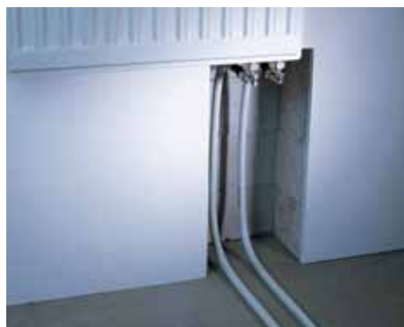
Непосредственное подключение труб к радиатору
