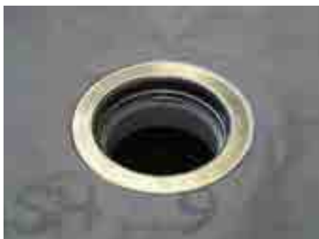
10. Зажать фильтрующий слой фиксирующим фланцем элемента HL350.0
