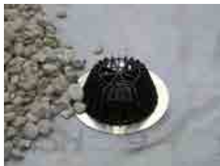
11. Установить листоуловитель, выполнить засыпку гравием (фракция: 20÷40 мм)
