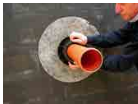
6. Затянуть фиксирующую гайку
