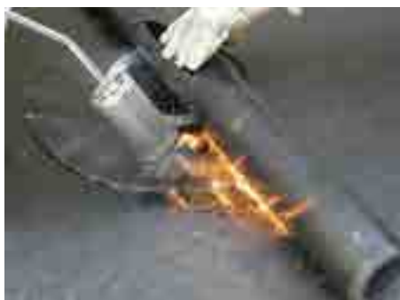
4. Наклеить 2-й слой гидроизоляции (до обжимного фланца)
