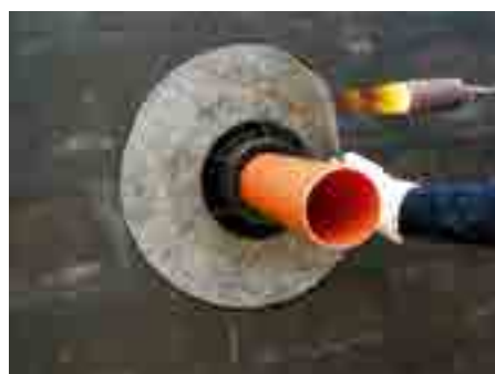
5. Приварить мембрану к битумному покрытию стены
