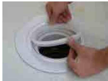
9. Убедиться в правильности установки прозрачного пластикового кольца
