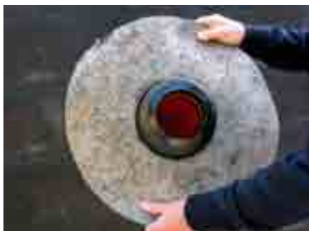
2. Надеть гидроизоляционную мембрану
