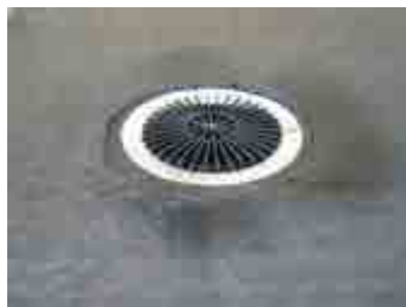
5. Так должна выглядеть воронка после укладки гидроизоляции
