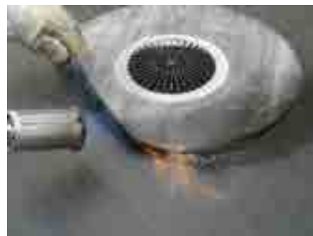
3. Приварить полимербитумное полотно воронки
