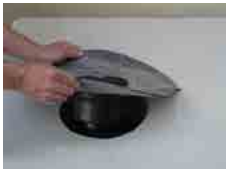
1. Проделать отверстие Ø 255мм, закрепить воронку HL62H
