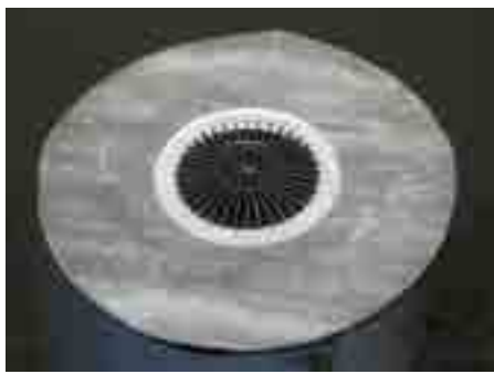
2. Нанести праймер, наклеить 1-й слой гидроизоляции
