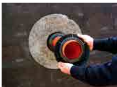
4. Установить фиксирующую гайку
