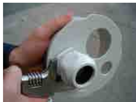
3. Установить и зафиксировать кабельные вводы.
