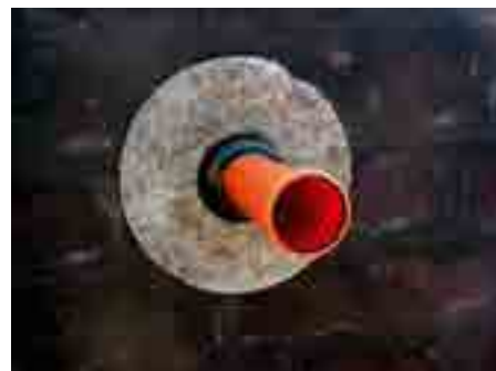
3. Придвинуть вплотную к стене
