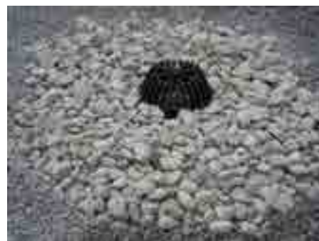
12. Засыпать гравием остальную поверхность кровли
