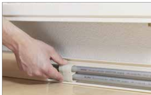
Рис. 16-36 Установка фиксаторов труб отопительной разводки
