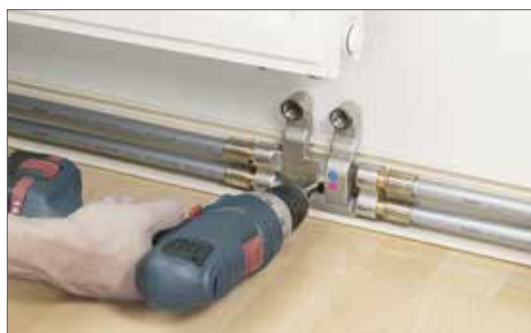
Рис. 16-35 Закрепление крестовины SL-RAUTITAN
