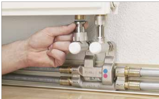
Рис. 16-26 Подключение угловых телескопических резьбозажимных соединений
