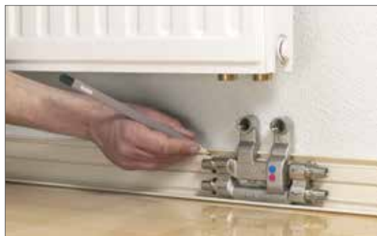
Рис. 16-32 Определение длины трубы
