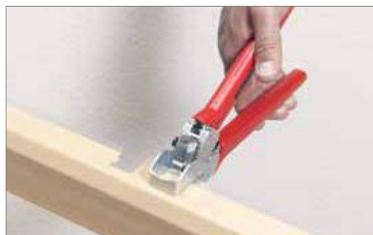
Рис. 16-39 Вырезка прямоугольных отверстий в крышке плинтусных каналов
