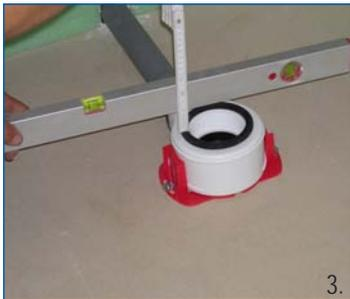
**DE** Ablaufkörper anschließen, Ablaufoberkante = Estrichoberkante -4 cm (bei Duschelementgröße ab 130 cm: -5 cm)
