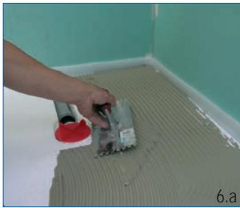
**DE Montage mit Unterbauelement HL523U:** Unterbauelement zuschneiden, einlegen, Klebmasse aufspachteln
