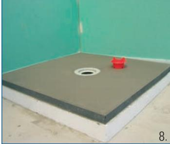
**DE** Duscheelement einsetzen
