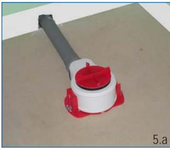
**DE Montage mit Unterbauelement HL523U:** Klebmasse auf die Rohdecke auftragen
