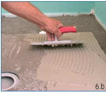
**DE Montage mit Füllmasse:** Klebmasse auf die Rückseite des Duschelements auftragen
