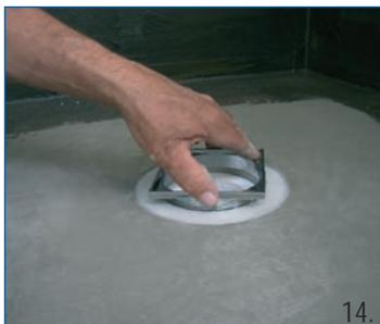
**DE** Aufsatzrahmen einsetzen, Höhe einstellen, Baustützrahmen einsetzen
