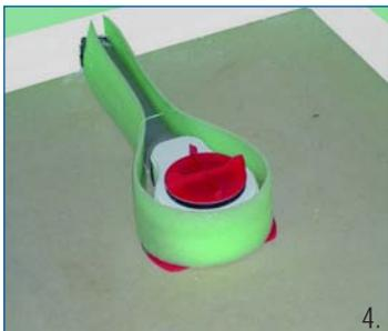
**DE** Bauschutz mit dem Schraubventil einsetzen, Dämmstreifen anbringen, Montage mit Fullmasse: Ablauf ummanteln
