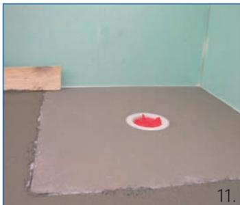
**DE** Bei Einbau von Unterbauelement HL523U: Estrich abziehen, aushärten lassen
