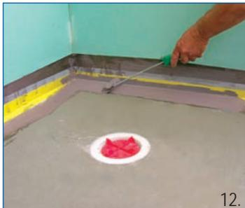
**DE** Abdichtband mit Dichtmasse anbringen
