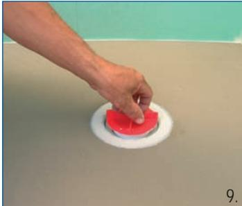
**DE** Einschraubteil einsetzen, mit Bauschutz festziehen
