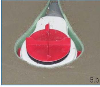
**DE Montage mit Füllmasse:** Füllmasse einbringen und auf Höhe der Ablaufoberkante einengen, Ablaufrohr freilegen, aushärten lassen.
