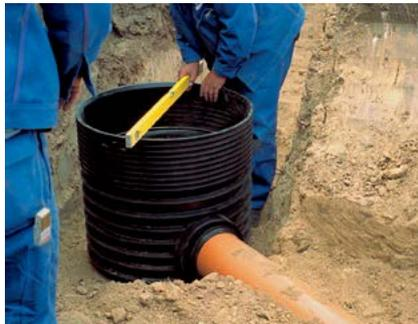
2. Днища устанавливаются на стабильной выровненной почве и 5-10-сантиметровой неуплотненной подсыпке из песка. Днища колодцев Tegra с двойным дном требуют локального 10-сантиметрового заглубления по отношению к траншее для канализационного трубопровода. В таком образом приготовленной почве установить днище. Верх днища необходимо выровнять.
