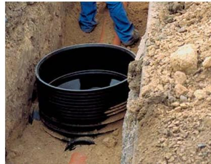
3. Подключить канализационные трубы к днищу путем вдавливания их в раструб – в патрубках с регулируемыми раструбами (диапазон кругового регулирования  $\pm 7,5^\circ$  на каждом из патрубков). Используемый диапазон регулировки по мере возможностей равномерно распределить на входной и выходной патрубки. Для того, чтобы обездвигнуть соединенный канализационный узел, рекомендуется засыпка траншеи до высоты как минимум 10 см выше трубы. Соединительный раструб к шахтной трубе остается выше обсыпки.
