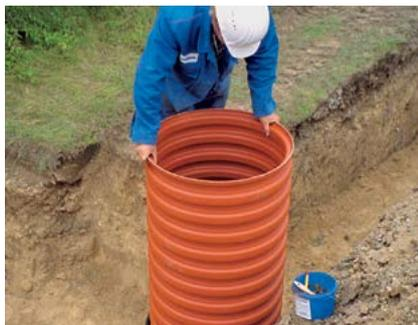
8. Шахтную трубу с установленным уплотнителем вставить в раструб днища.
